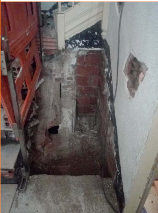
Foto 4. Final fossat ascensor
